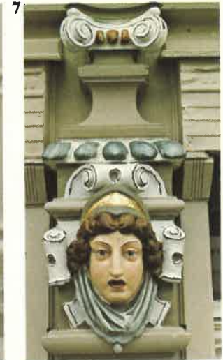
5 bis 7 Dieses Gebäude liegt an einer der verkehrsreichsten Stellen Mönchengladbachs. Es wurde im Jahre 1973 neu gestrichen. Im Bereich des Dachüberstandes befinden sich Verzierungen aus Holz. Bildliche Darstellungen im Putz wurden bis ins Detail ausgemalt. Die Ölvergoldung erfolgte mit 23 \frac{3}{4} karätigem Blattgold. Der Eigentümer erhielt eine Prämie.
