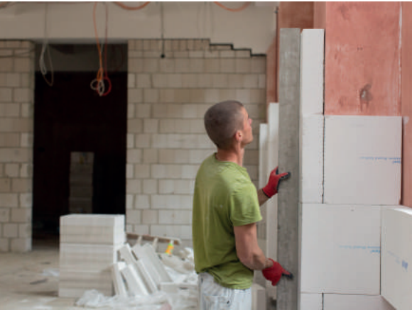
3 TecTem- Insulation Board Indoor von wird komplett ohne Dampfsperre montiert.
