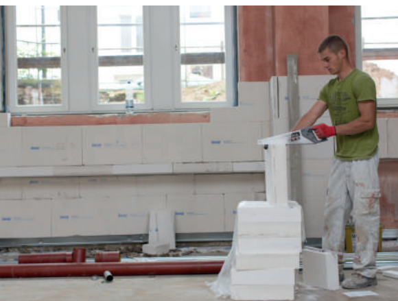
4 Platten können für Passstücke einfach mit einem feinzahnigen Fuchsschwanz auf beliebige Maße zugeschnitten und dann waagrecht im Verband angesetzt werden.
